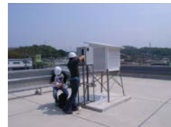
腐食環境調査風景
